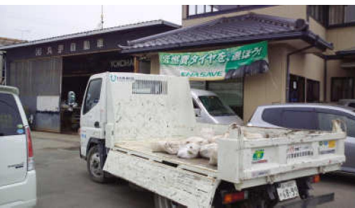
2011:07:04 石巻市渡波 土嚢搬送
