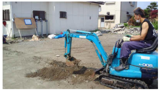
2011:06:29 石巻市黄金浜 ミニコンボ回送下水工事
