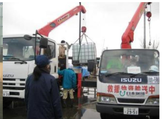
石巻市中央日本財団浄水プラント
