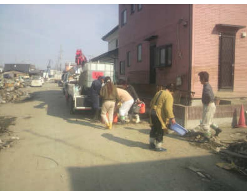
2011.03.29 石巻市緑町給水
